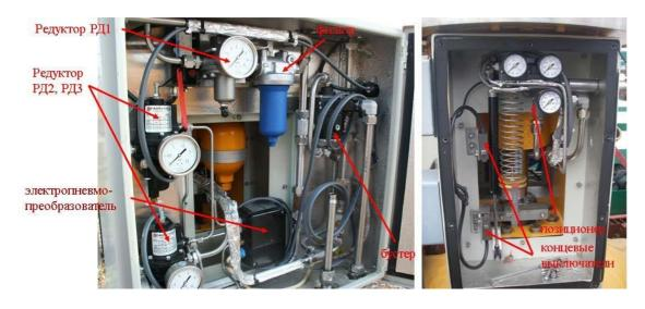
Рисунок 18. Приборная часть антипомпажного клапана типа RZD фирмы «Mokveld Valves».
