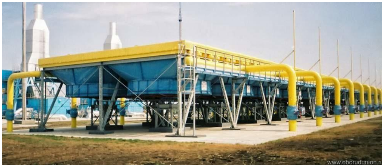
Рис.38. Блочная компоновка АВО типа АВГБ
