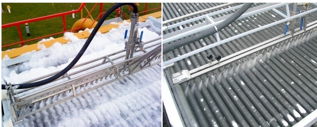
Рис. 33. Устройство для промывки наружной поверхности труб трубного пучка АВО газа – УНП01
