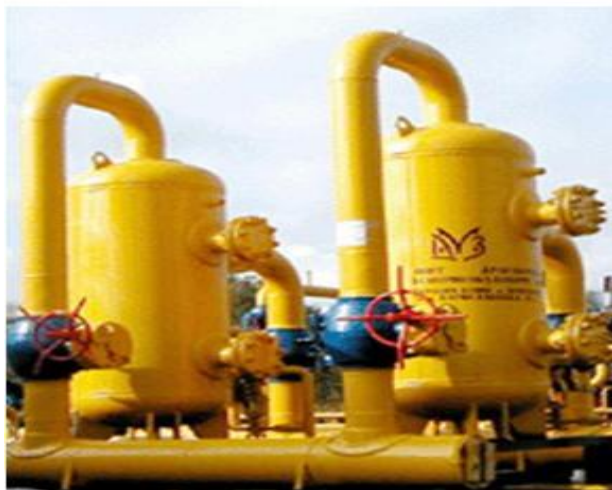
Рис. 8- Узел предотвращения гидратообразований
