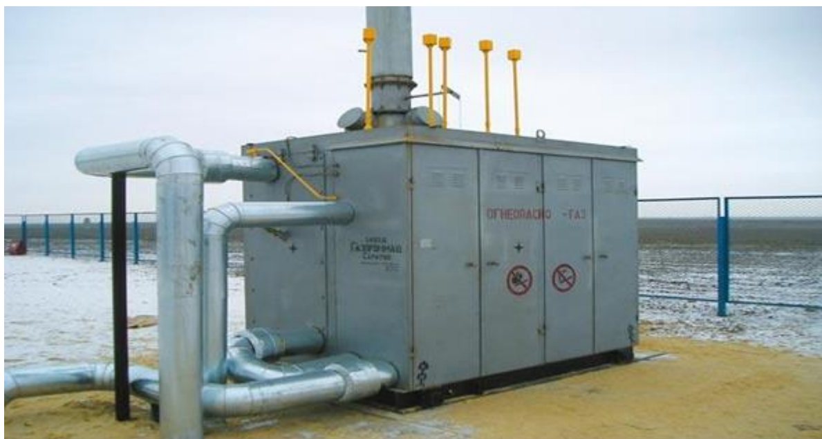
Рис.10 - Узел редуцирования
