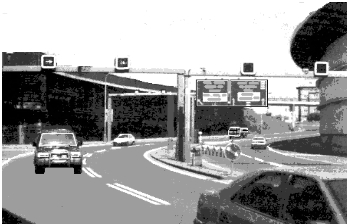
Рисунок 18 - Пример применения управляемых дорожных знаков, работающих на основе световода или трехгранных поворотных призм для изменения направления транспортных потоков (Республика Чехия)
