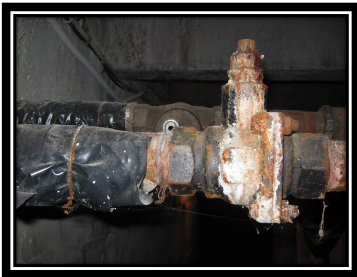
Рисунок 13. – Фото фиксация дефектов холодного и горячего водоснабжения
