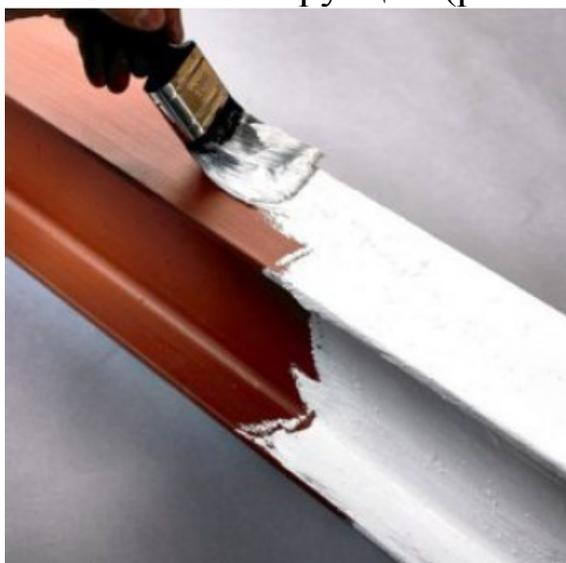
Рис. 5.4. Способ нанесения защитного покрытия на металлическую поверхность.
