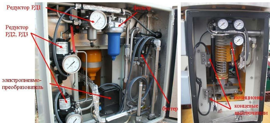
Рисунок 18. Приборная часть антипомпажного клапана типа RZD фирмы «Mokveld Valves».
