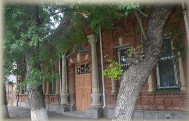
Здание первой почты г. Майкопа
